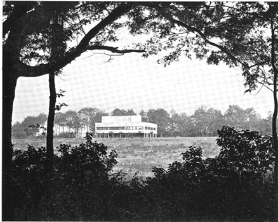
Vue générale General view Gesamtansicht
