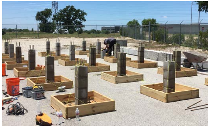
(c) Reinforcement cage (d) Column and base arrangement
