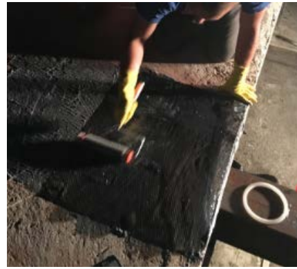
(d) Applying saturates CFRP
