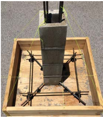
(c) Reinforcement cage (d) Column and base arrangement
