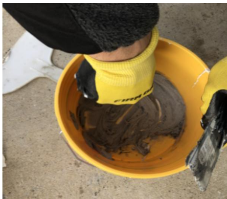
(d) Mixing of Sikadur 31
