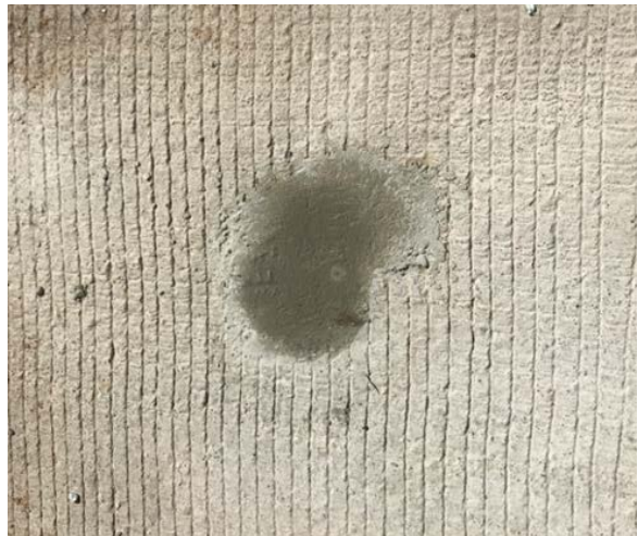
(d) Patched borehole
