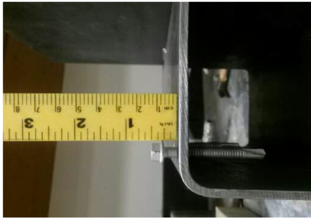
Fig. AF.1 – 1/4" Cantilever
