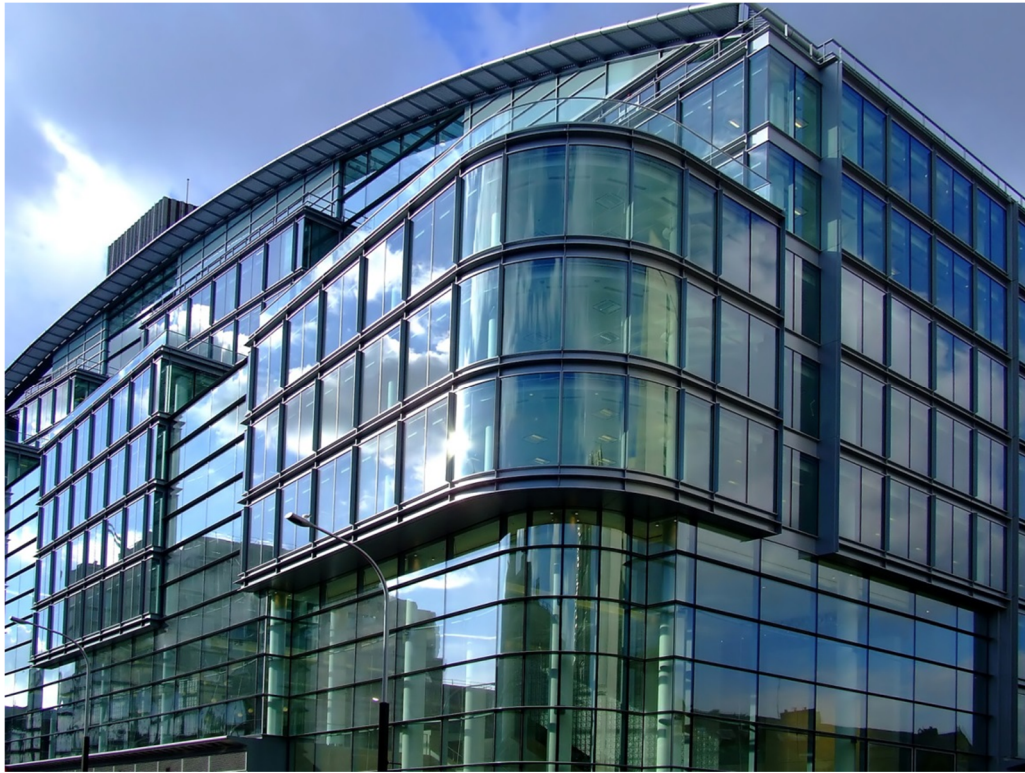
Fig. AA.1 – Curtain Wall
